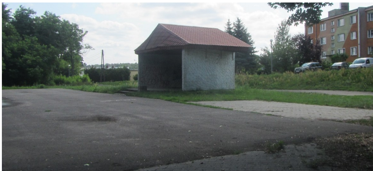
Nawierzchnia asfaltowa i zadaszona budowla
