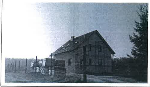
Fot. 1. Budynek mieszkalny jednorodzinny na działce o nr ewid. 909/2.
