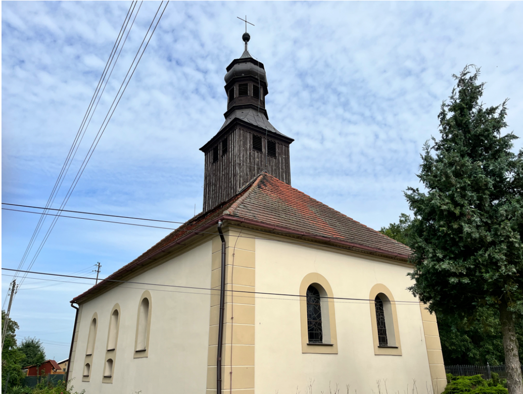
Fot. 1. Elewacja wschodnia i południowa korpusu kościoła i wieży z widocznymi połaciami dachu, aktualny stan zachowania.
