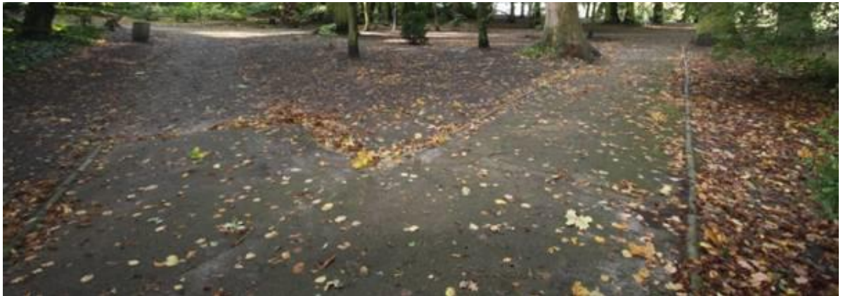
Połączenie chodnika betonowego ze ścieżką nieutwardzoną.
