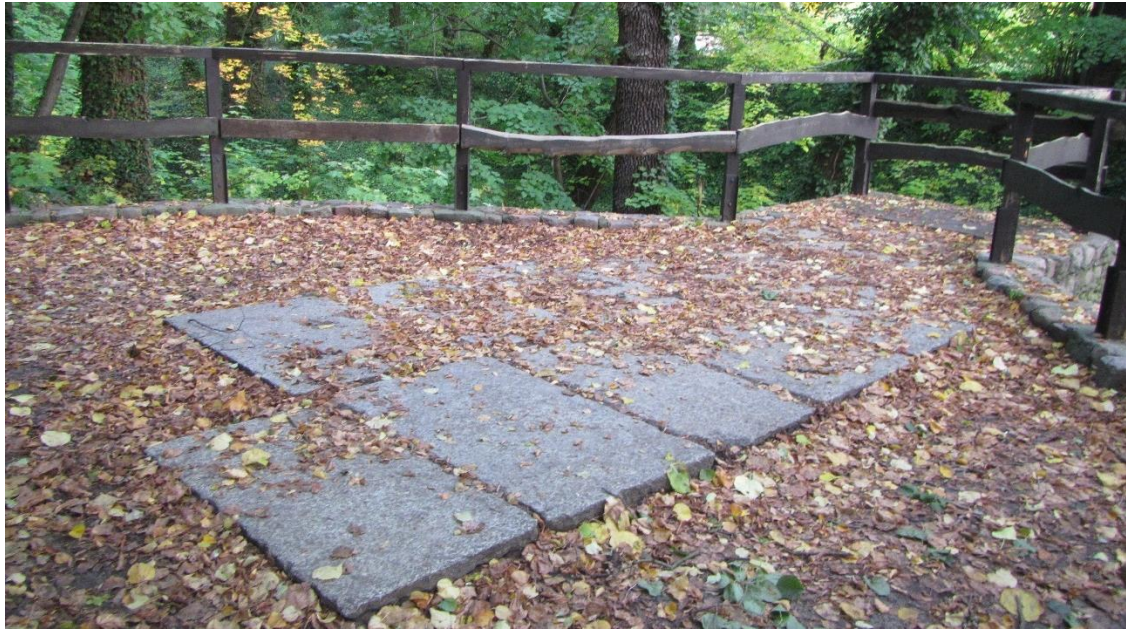
Granitowe płyty na powierzchni tarasu
